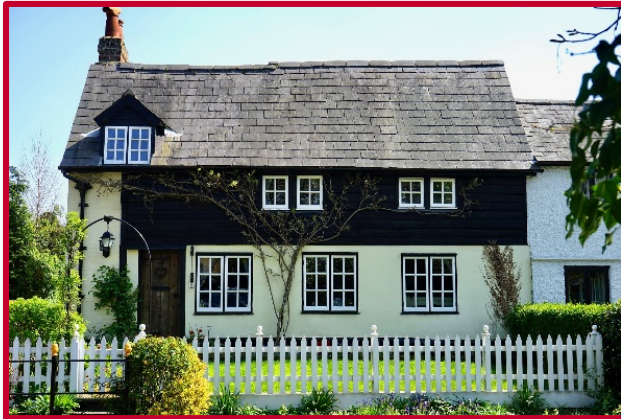
Vermutlich beschädigtes Objekt
